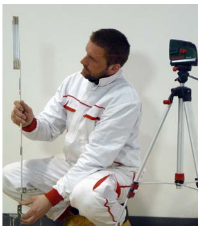
Zaměření nivelety a stanovení výšky podlahové konstrukce pomocí nivelačního laseru.
