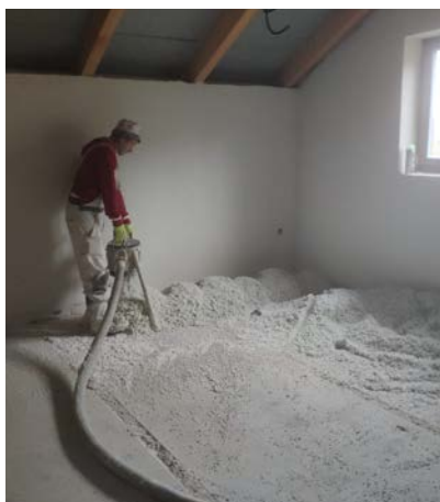
Izolační směs ThermoWhite je na realizovanou plochu vháněna z míchacího přístroje pomocí hadic.
