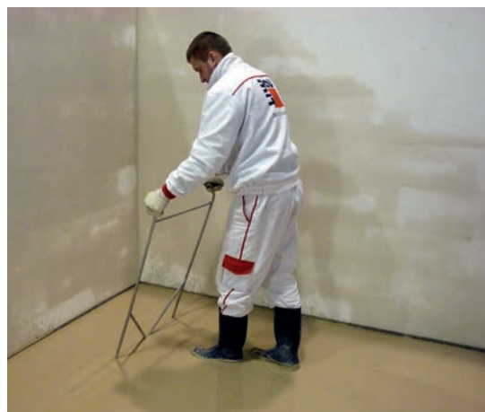
Odvzdušnění litého potěru vibrační latí.
