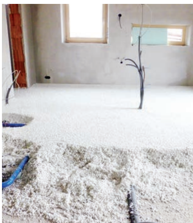
Směs je nutné poté zarovnat do požadované výšky pomocí srovnávací laťe a poté jemně ztuhnit.
