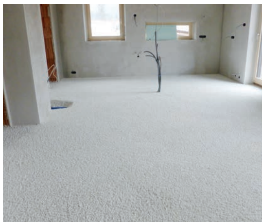
Po celoplošném vyrovnání a ztuhnutí je nutné směs nechat vyzrát minimálně 48 h (v závislosti na klimatických podmínkách).
