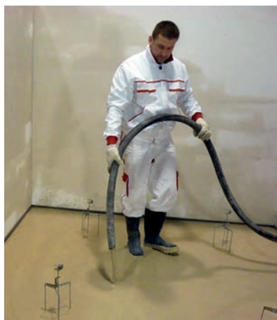
Lití samonivelačního potěru Baumit Alpha.
