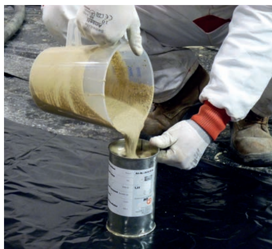
V případě nevytápěného potěru je nutné na podklad celoplošně rozprostřít Separální PE folii. Před zahájením lití směsi Baumit Alpha je nutné ověřit konzistenci směsi pomocí rozlívové zkoušky.
