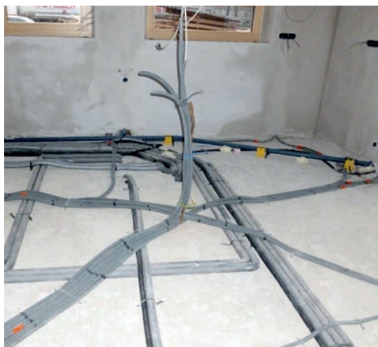
Připravený podklad před aplikací izolačního systému ThermoWhite. Jednou z výhod systému je absence jakéhokoliv prořezu.
